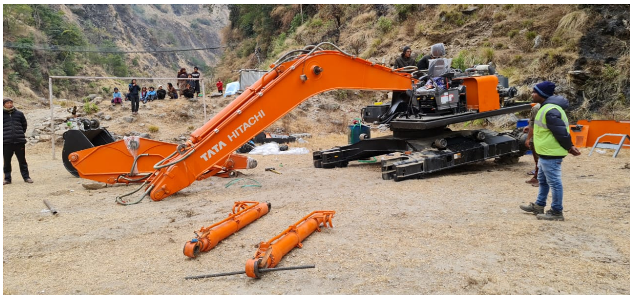
नया Excavators खोलेर हेलिकप्टरबाट दहरे लान तयारी अवस्थामा
