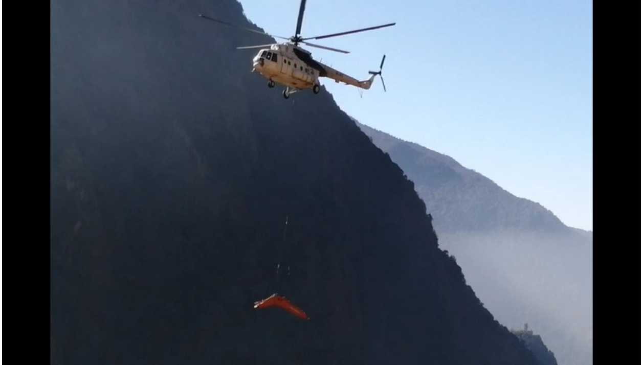
Excavators खोलेर हेलिकप्टरबाट दहरे लाने कार्य हुँदै
