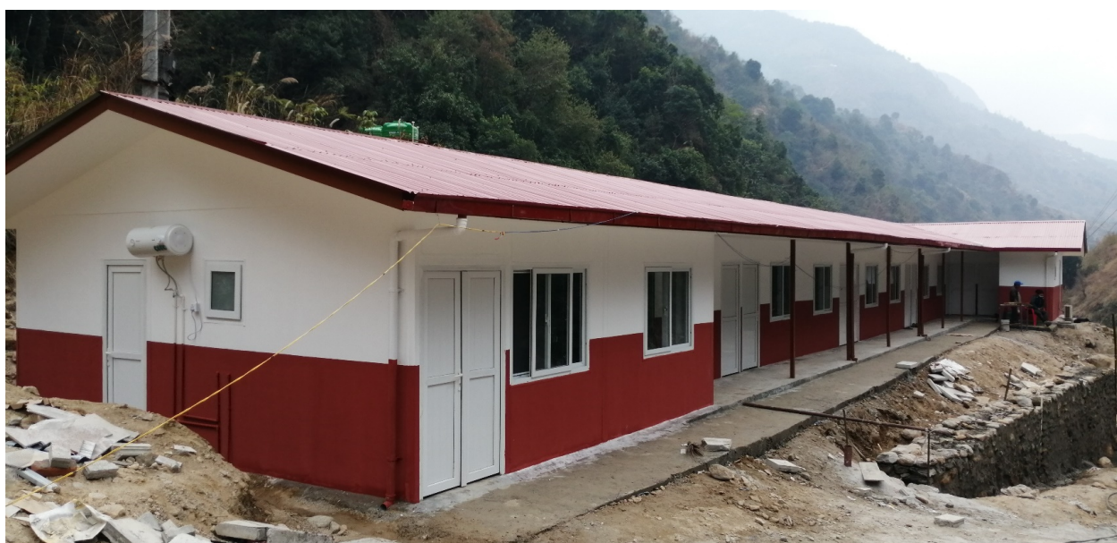
कर्मचारी क्याम्प तथा साइट अफिस भवन निर्माण सम्पन्न भैसकेको ।
